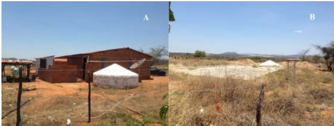
Figura 4: Cisternas da P1MC e P1+2 encontradas no lote 06. (A) Cisterna de Placas e (B) Cisterna Calçadão.
