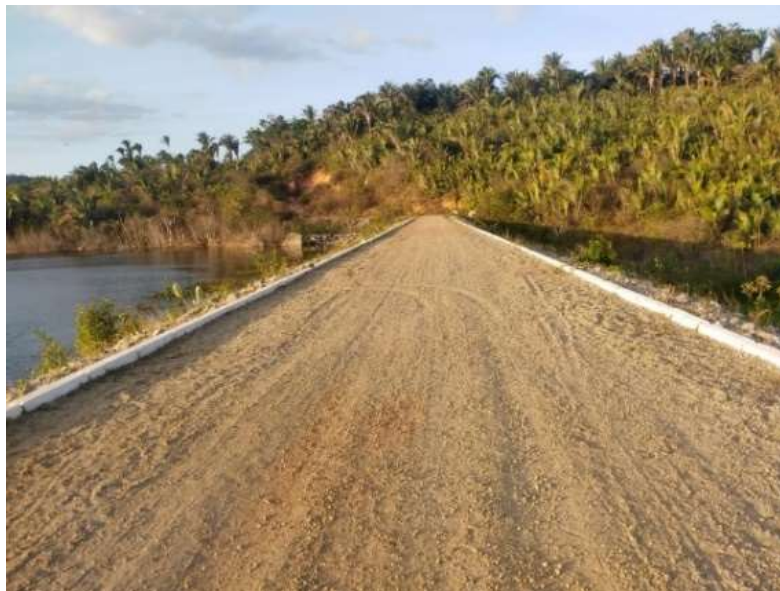
Figura 4 – Crista da barragem de enrocamento do Açude Público Jenipapo por onde passa uma estrada de terra.
