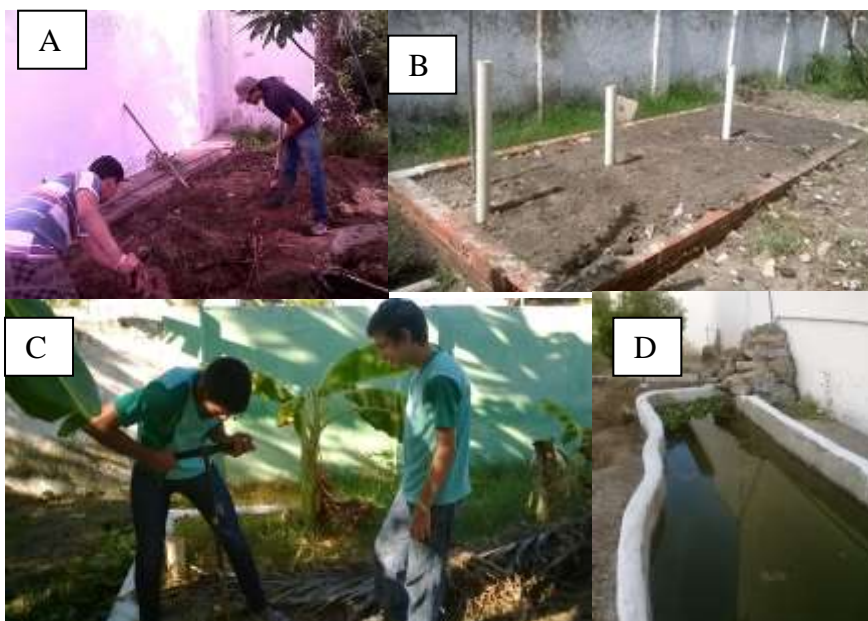
Figura 3: execução das ações e construção dos equipamentos sustentáveis
