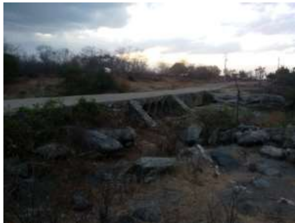
Figura 9 – Sangradouro do lado da ombreira esquerda da barragem.
