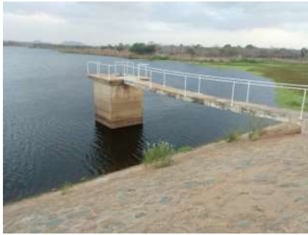
Figura 8 – Barragem de terra revestida de pedra e a tomada d'água de concreto armado.
