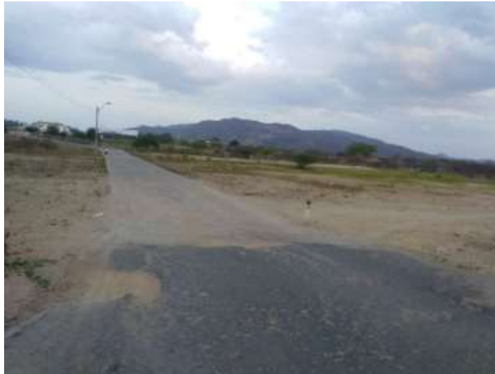
Figura 5 – Sangradouro e a pista de rolamento sobre o sangradouro.
