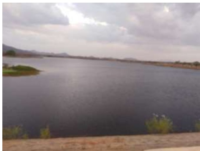
Figura 3 – Reservatório do açude com boa quantidade de água.
