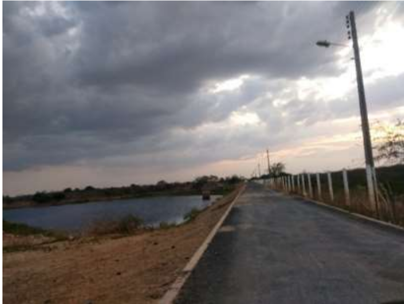
Figura 4 – Barragem do Açude Patos onde em sua crista existe uma pista de rolamento.
