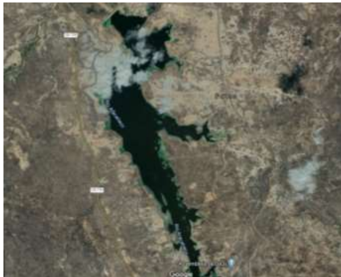
Figura 2 – Reservatório do Açude Patos.
