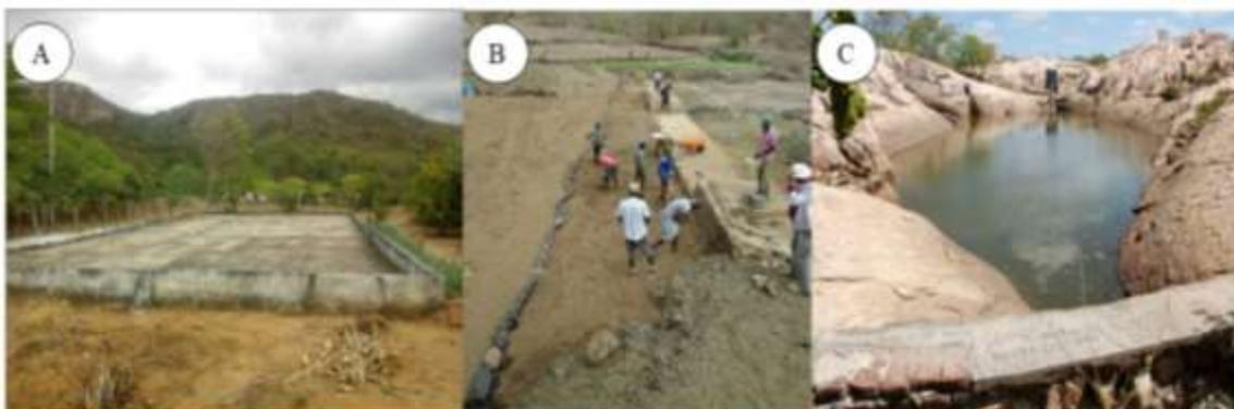
**Figura 1:** a) Cisterna de calçadão b) Barragem subterrânea c) Tanque de pedra
