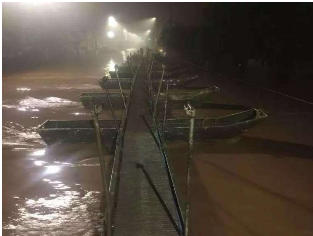
Figura 3 - Passadeira construída na entrada da ponte nova
